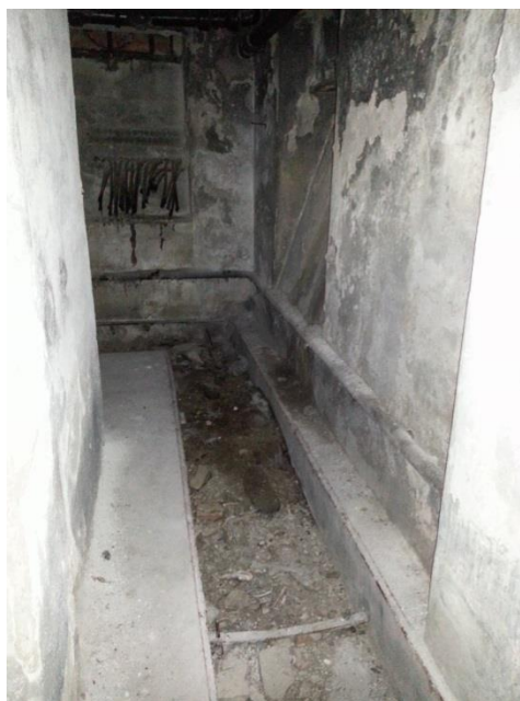
Interno piano seminterrato
