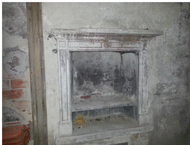
Interno piano rialzato
