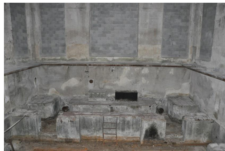
Interno piano seminterrato
