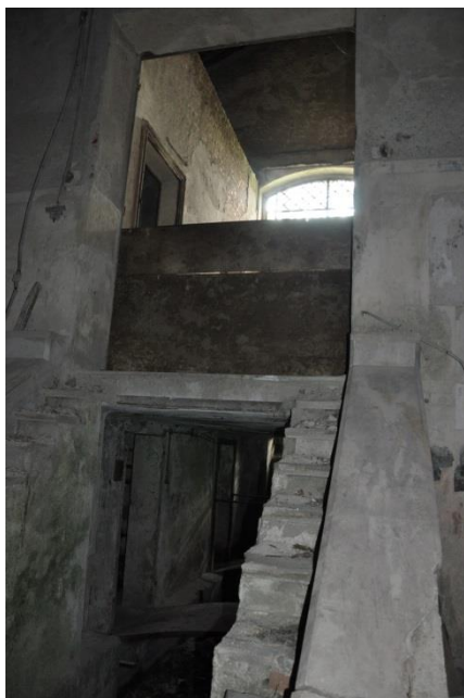
Interno piano seminterrato
