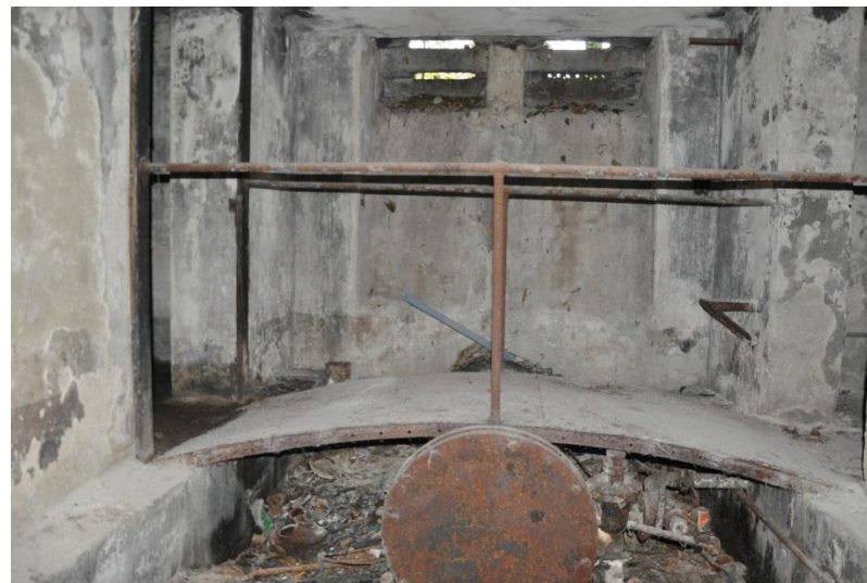
Interno piano seminterrato
