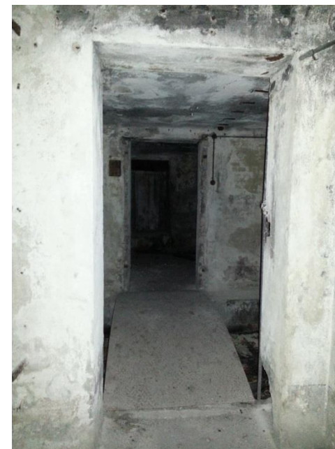
Interno piano seminterrato
