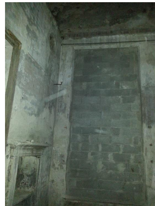
Interno piano rialzato
