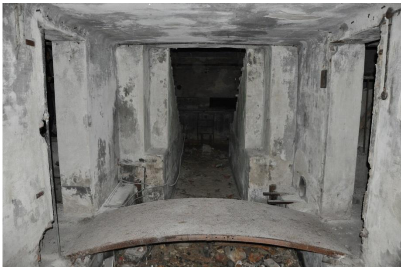
Interno piano seminterrato
