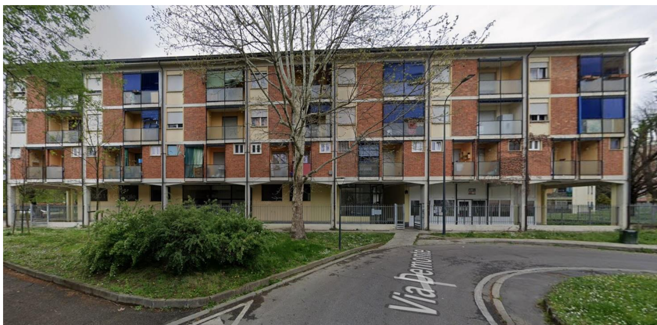
Complesso via Demonte 8
