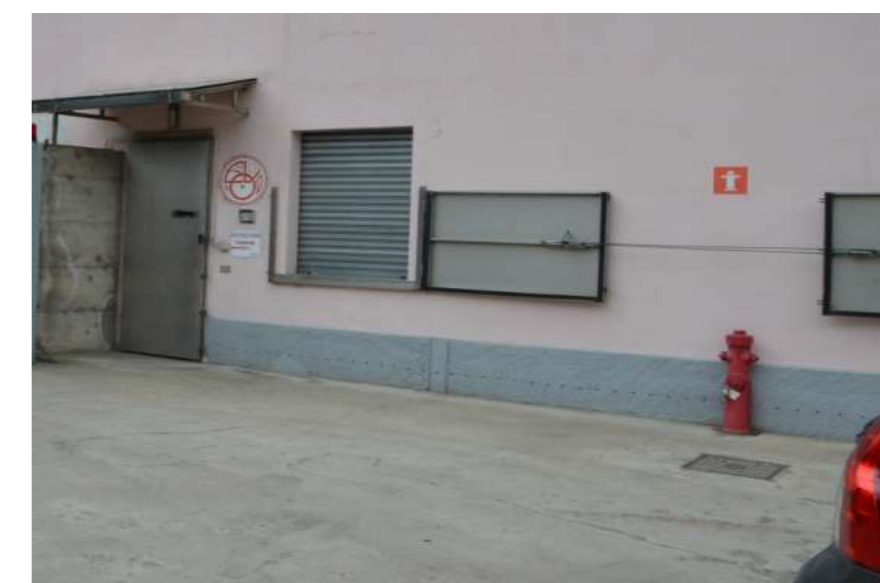
Figura 18: Esempio di difesa passiva di stabilimento produttivo lungo l'Oloni.
